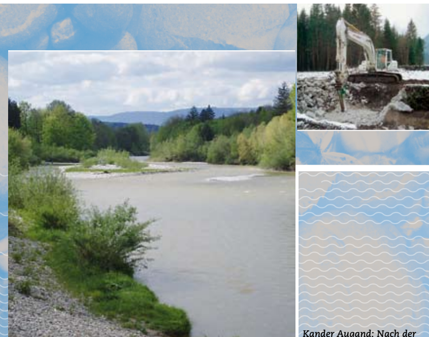
Kander Augand: Nach der Aufweitung hat sich ein dynamisches, verzweigtes Gerinne gebildet.
