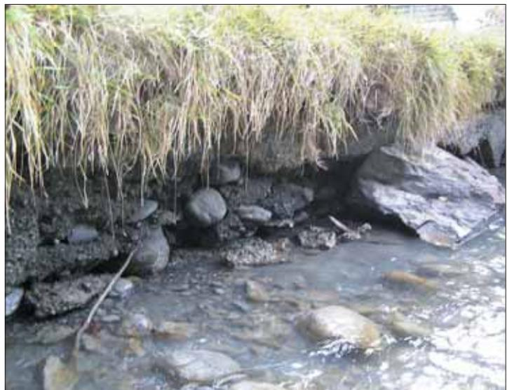
Die beiden Fotos zeigen beschädigte Uferverbauungen. Im Bild oben wurden die Längshölzer freigelegt, währenddem unten die Betonmauer als Folge von Unterspülungen stark zerstört ist.
